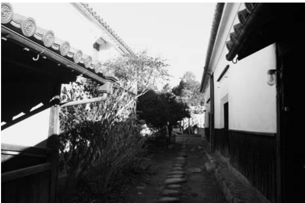
内蔵（左）と酒蔵（右手前）・角蔵（右奥） 主屋裏口から
