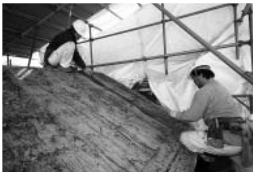
屋根下地杉皮 取り外し
