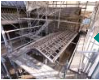
野地を取り外した状態
