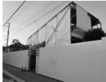
仮の素屋根設置状況
