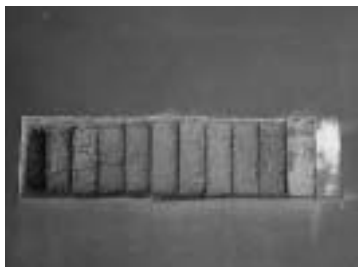
土壁解体調査状況
