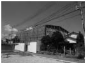
素屋根設置状況
