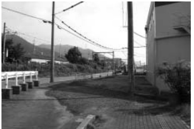
整備が進む町道駅南幹線
