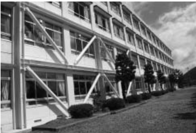
耐震化が完了した福崎東中学校
