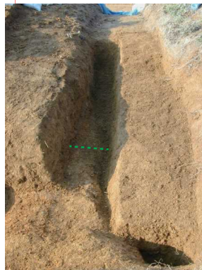
西側トレンチ (点線が裾部)
