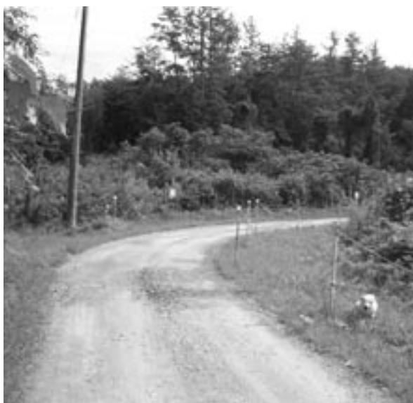
拡幅、舗装が待たれる魔のカーブ石引線
