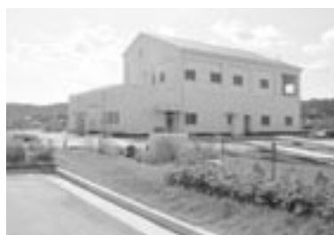
公共下水道汚泥処理棟
