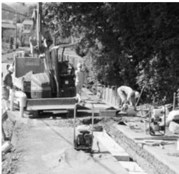
工事が進捗する下水道工事（福田地区）
