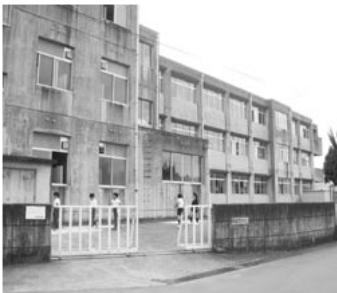
耐震工事が待たれる福崎小学校北校舎
