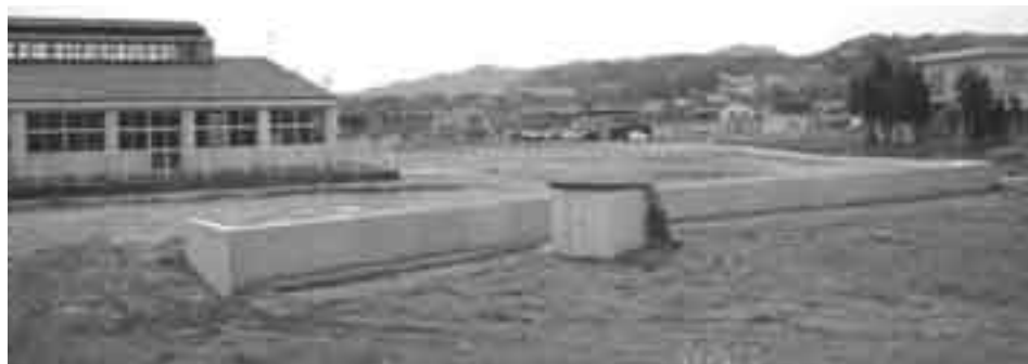
造成工事ができた統合保育所
