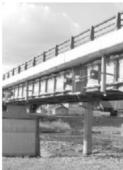
耐震補強工事が完成した神崎橋
