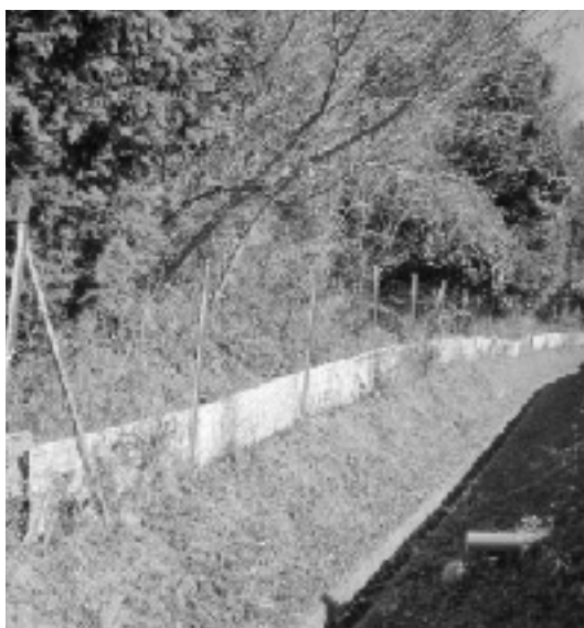
現在ある防護柵（井ノ口）
