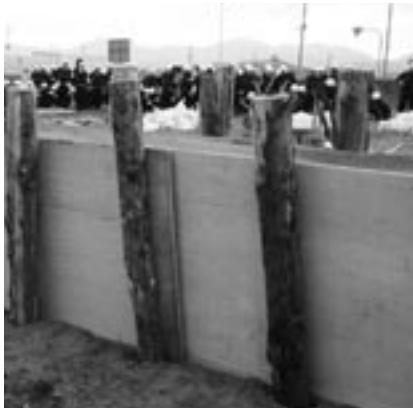
水防訓練の成果（せき板工法）
