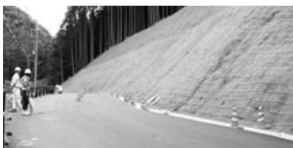
7月20日 県道田口福田線の工事現場
