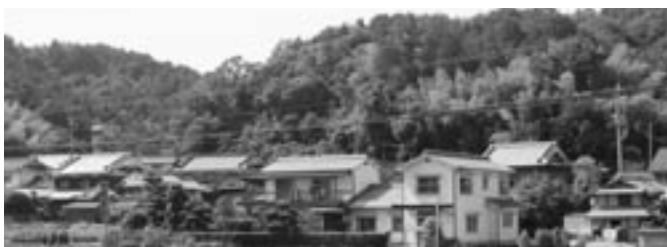
急傾斜地対策予定地
