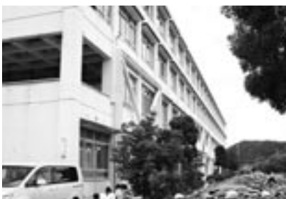
東中学校の教室の窓
