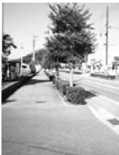
自転車専用レーンがない道路
