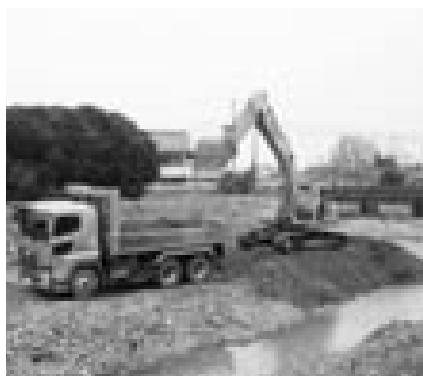
浚渫工事中の七種川
