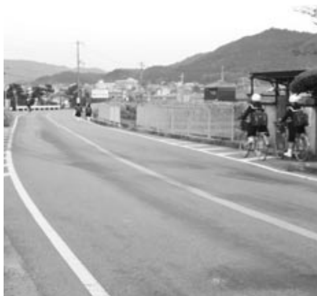
歩道が途切れて危険、車道の端を歩く中学生
