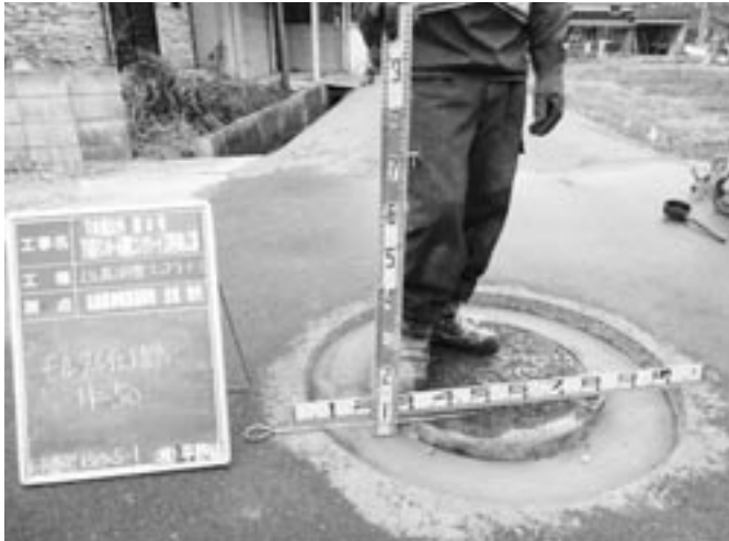
円形工法での手直し工事
