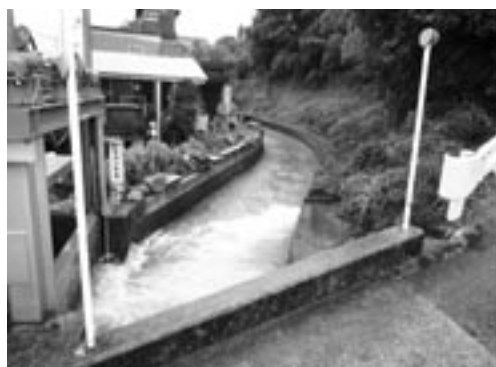
豪雨で増水した水路(西光寺・仁王門付近)
