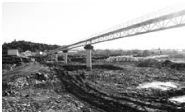
井ノ口水管橋（西側から）
