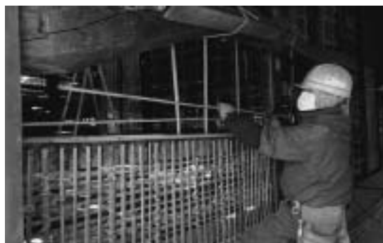
▲小舞組(土壁の下地)修理のようす
