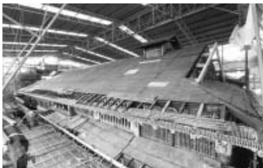
▲野地板(屋根の下地)修理のようす
