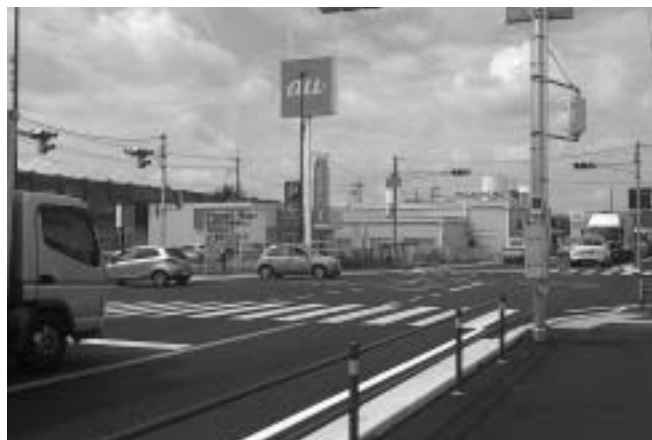
交差点改良工事により渋滞が緩和された県道三木穴栗線 (南田原交差点)
