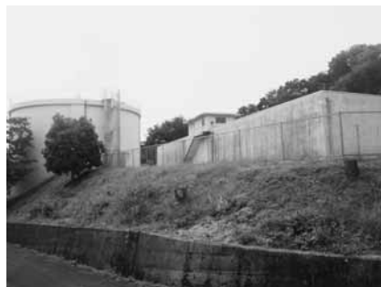
工業団地配水池
