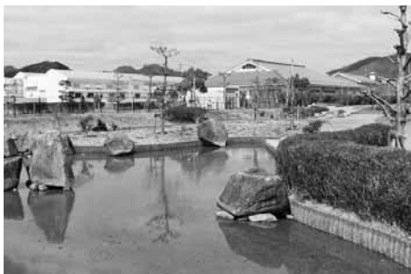
福崎町浄化センターとせせらぎ空間
