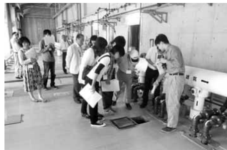
福崎町浄化センターでの視察の様子
