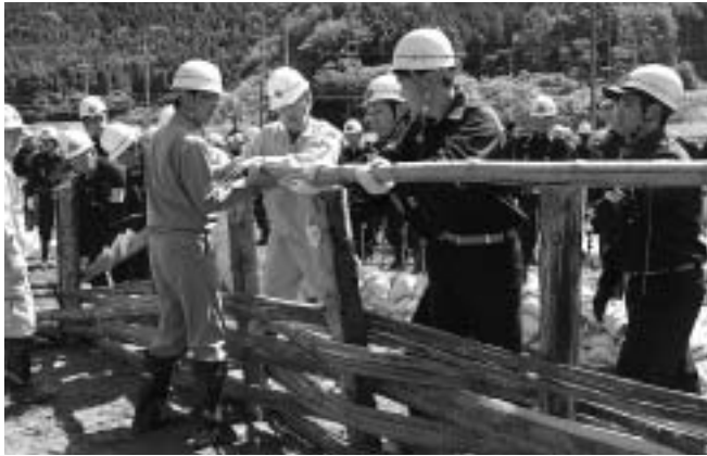
竹しがらみ工法
