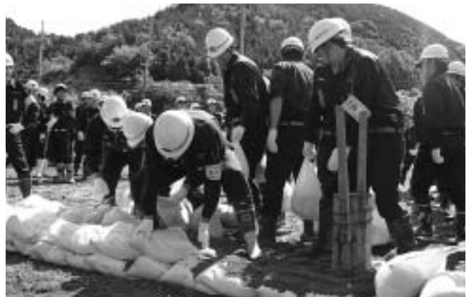
積み土のう工法
