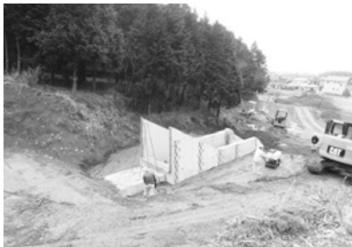
工事中のイマ谷池
