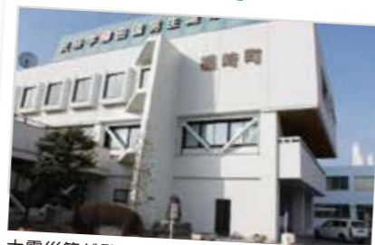
庁舎耐震工事
