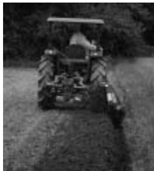
溝を作る(明きょ排水)
