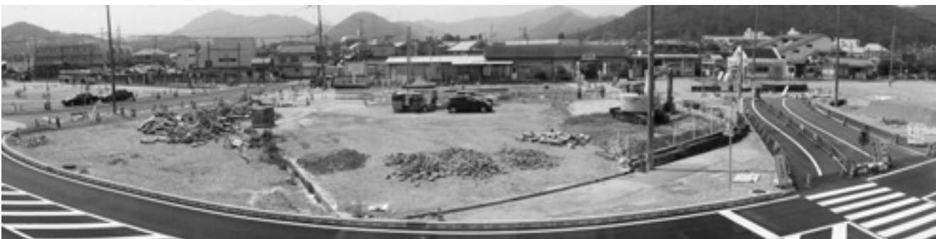
福崎駅前の工事の様子（7月17日）
