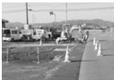
改良が進む南大貫の交差点
