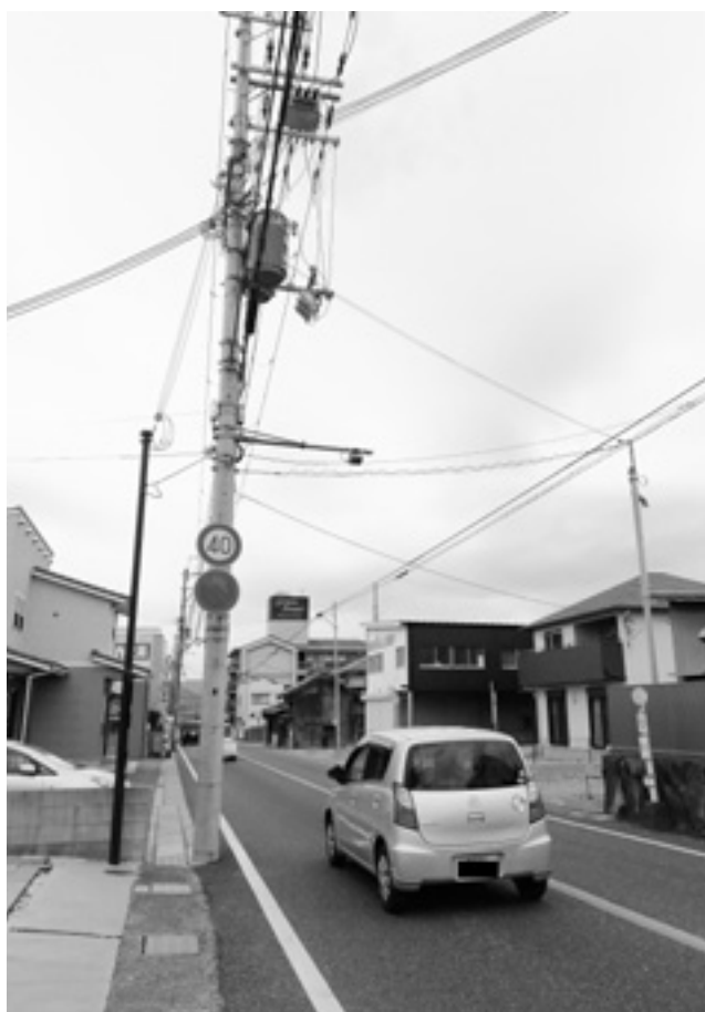
白線と側溝の間に立つ電柱
