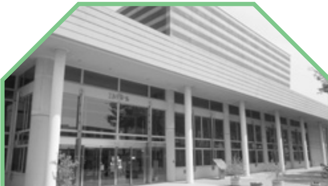
エルデホール空調改修 2億1700万円
