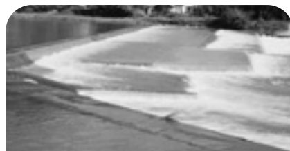
新町大井堰災害復旧工事
