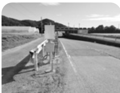
大貫山田線冠水対策工事
