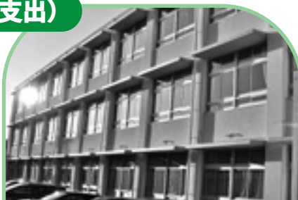
福崎小学校北校舎長寿命化改修工事 1億4264万円
