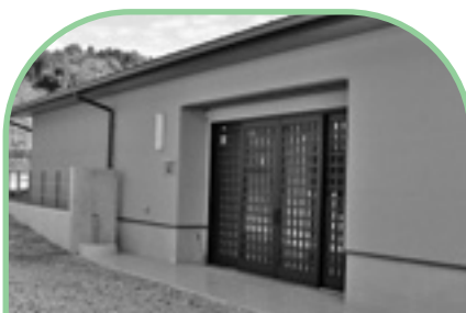
三木家住宅展示兼収蔵施設整備工事 2507万円
