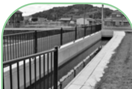
直谷第2雨水幹線工事 3934万円
