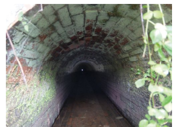
西光寺野疎水路の煉瓦トンネル
