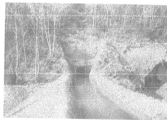
7号トンネル出口完成
