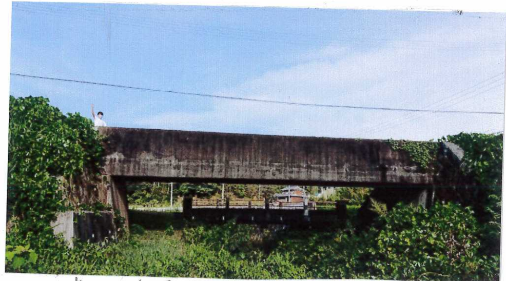
妙徳山前雲津川コンクリート水道橋(現在)
