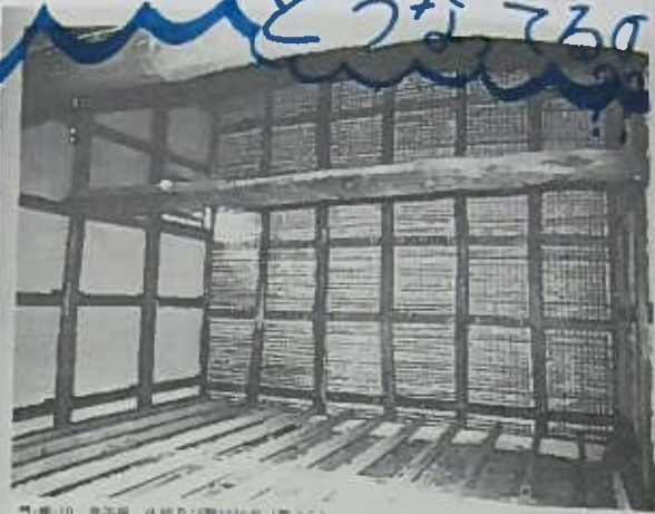
門・壁・10 内側面、床及び障子付成（奥より）
