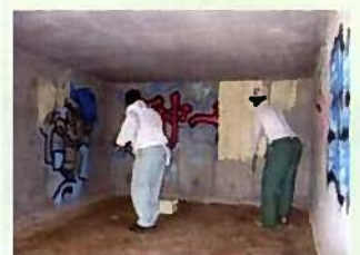
壁の落書き消し
