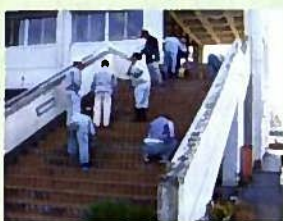
階段の修理・清掃
