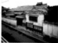
保存修理工事前の三木家住宅
