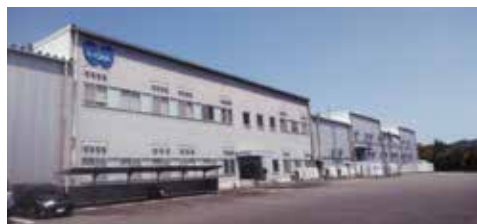
福崎物流センター外観
