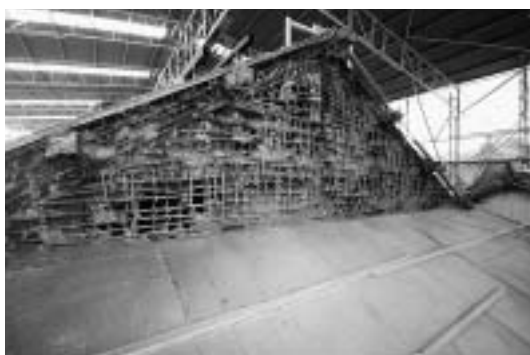
木で組まれた壁下地
