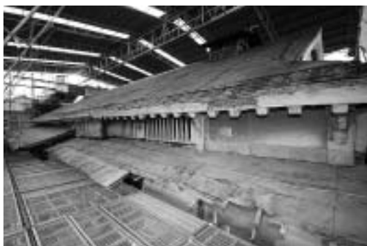
修理の状況（野地板の状態）
