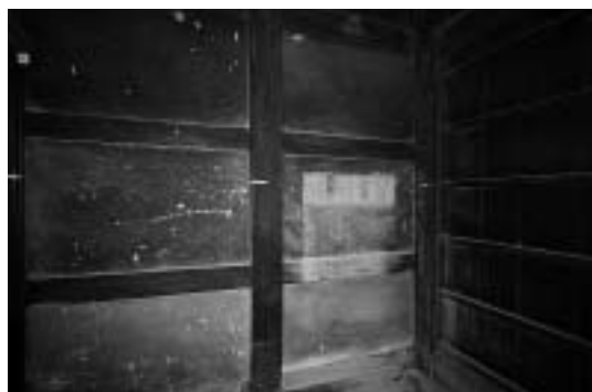
十一層塗り上げた土間の壁
