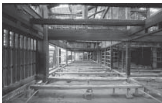
▲修理（軸組）の状況
