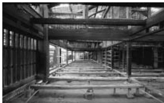
▲修理(軸組)の状況
