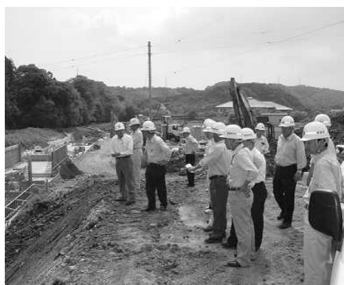
川すそ川改良工事現地視察（6月6日）
