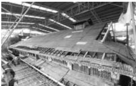
▲野地板(屋根の下地)修理のようす
