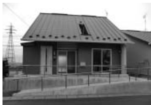
現在完成している災害公営住宅
