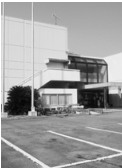
建設から43年が経過した文化センター
