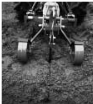
穴を掘る(暗きょ排水)
