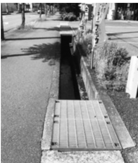
町道中島井ノ口線歩道の側溝
