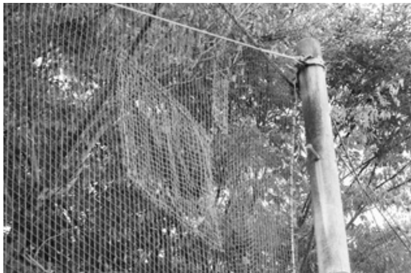
全て修復済みの防球ネット（福岡西中学校）
