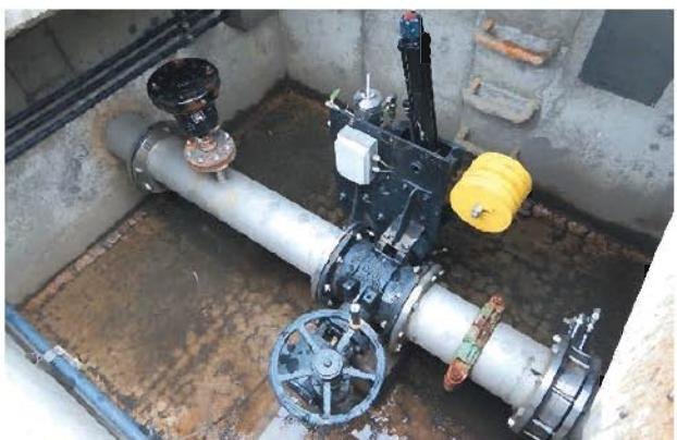
図3.3-6 緊急遮断弁(東部工業団地配水池)
