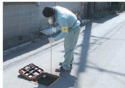
図3.4-5 漏水調査の様子
