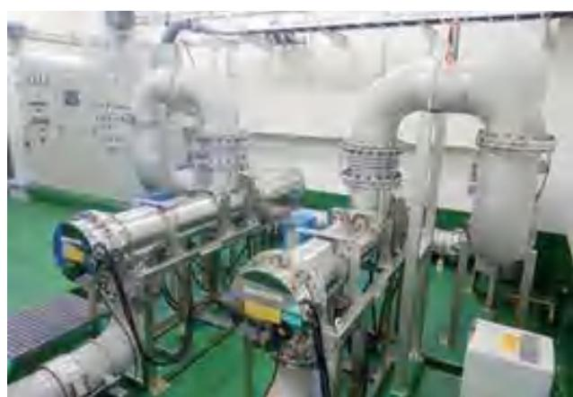
図2.4-5 福田水源地の浄水処理施設(左:急速ろ過設備、右:紫外線処理設備)
