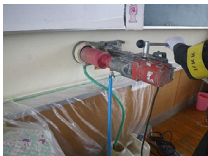
コア抜き作業
