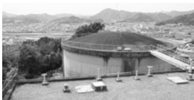
辻川山配水池
