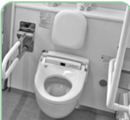
小学校・中学校施設長寿命化 改良事業(トイレ改修) 3億5357万円
