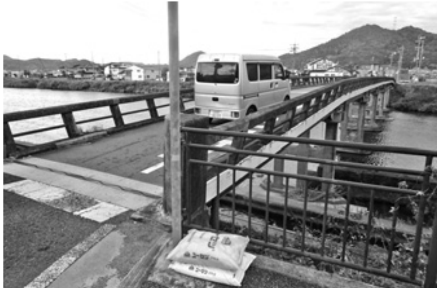
月見橋通行状況
