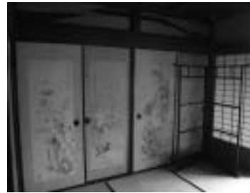
改修工事前の離れのふすま
