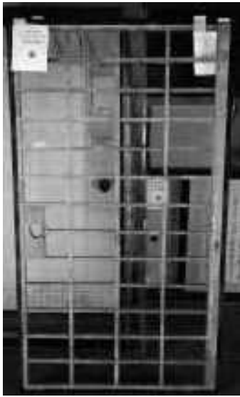
下張りを剥がした後の外枠と下地骨
