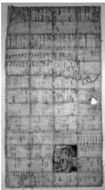
傷んだ部分だけが張り替えられている下張り
