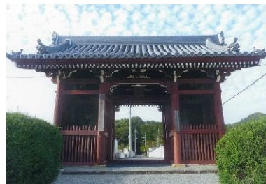
神積寺仁王門の修理
